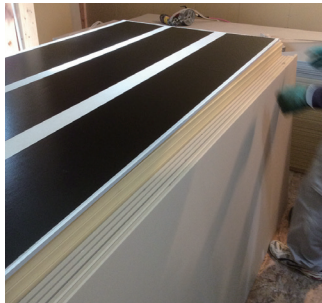
〈施工〉 石膏ボードに3列 貼付面積約80%
