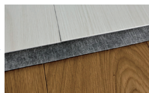
ビニル床タイルを重ね張り
