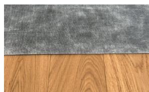
TS-UL20 を重ね張り
