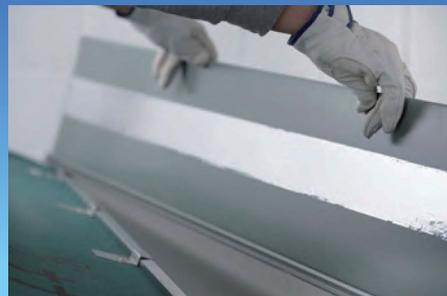
〈施 工〉 金属屋根の動き幅に対して、貼付面積約 30%
